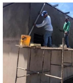
Foto 15 – Sarrafeamento e desempeno do reboco. Fonte: Próprio autor.
