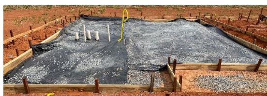
Foto 2 – Lona preta posicionada no radier. Fonte: Próprio autor.
