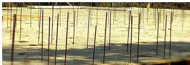
Foto 3 – Arranques fixados após a concretagem. Fonte: Próprio autor.
