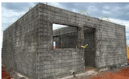
Foto 12 - Chapisco. Fonte: Próprio autor.
