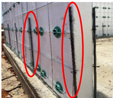
Foto 6 – Painel monolítico encaixado às barras. Fonte: Próprio autor.
