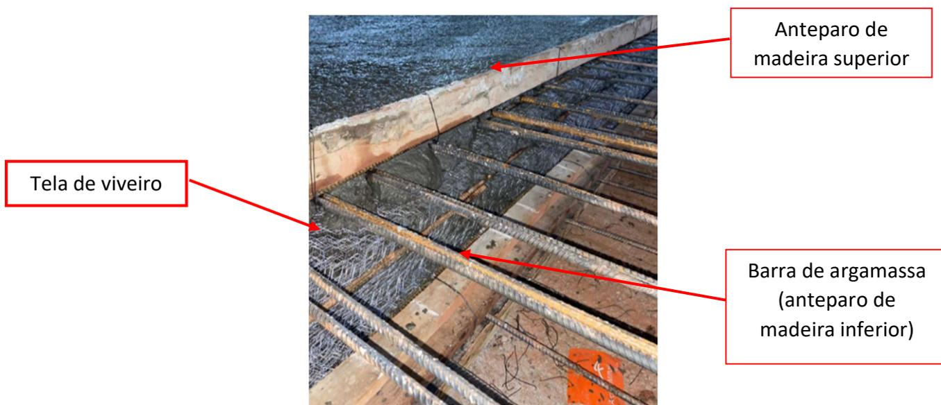
**Figura 19: Materiais utilizados para juntas de concretagem**
