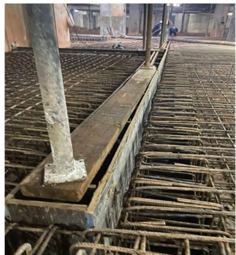
**Figura 9b: Montagem da fôrma**
