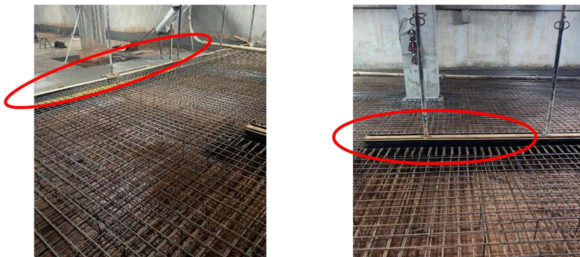
**Figura 12: Fôrma na grelha de água pluvial**
