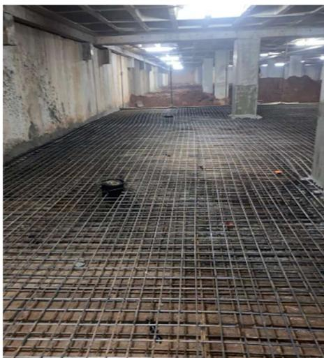
**Figura 9a: Montagem da armação**
