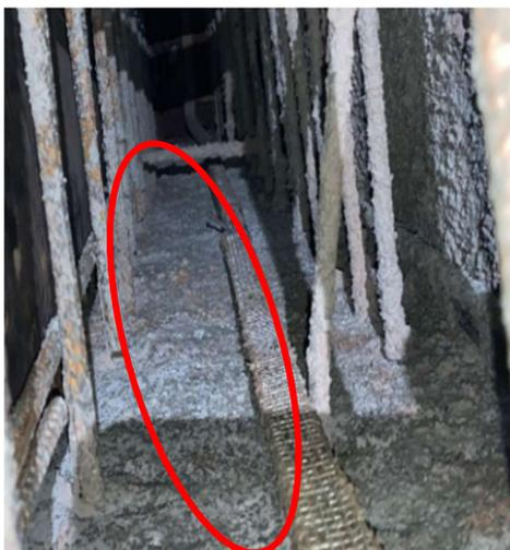
**Figura 20: Fita hidroexpansiva**
