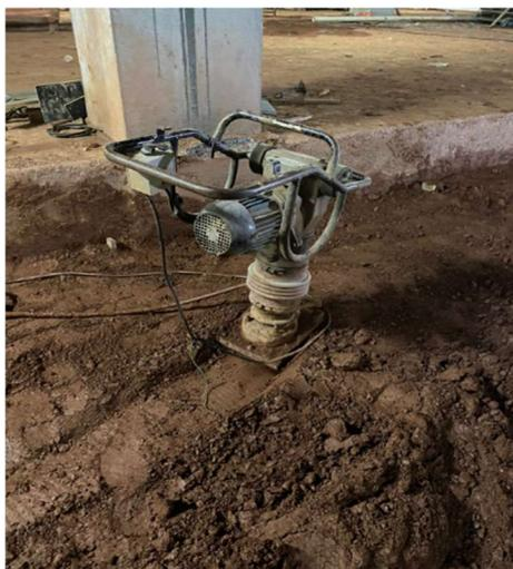
**Figura 5 – Compactador leve – “tipo sapo”**
