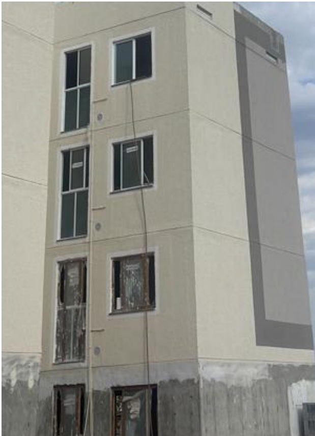
FIGURA 4 – PRUMADA DE ÁGUA EXTERNA FONTE: OS AUTORES
