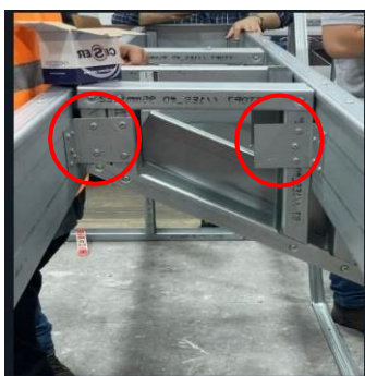
Foto 12: Fixação das cantoneiras de aço na escada, com parafusos auto brocantes
