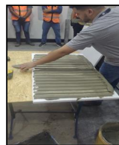
Foto 19: Aplicação do basecoat com desempenadeira dentada
