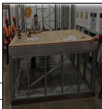
Foto 11: Laje com placa OSB 18 mm aplicada
