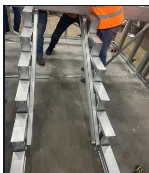
Foto 13: Fixação da estrutura da laje à escada
