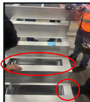
Foto 15: Aplicação da banda acústica nos degraus
