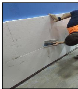
Foto 18: Placa SMART EIFS - Aplicação e lixamento
