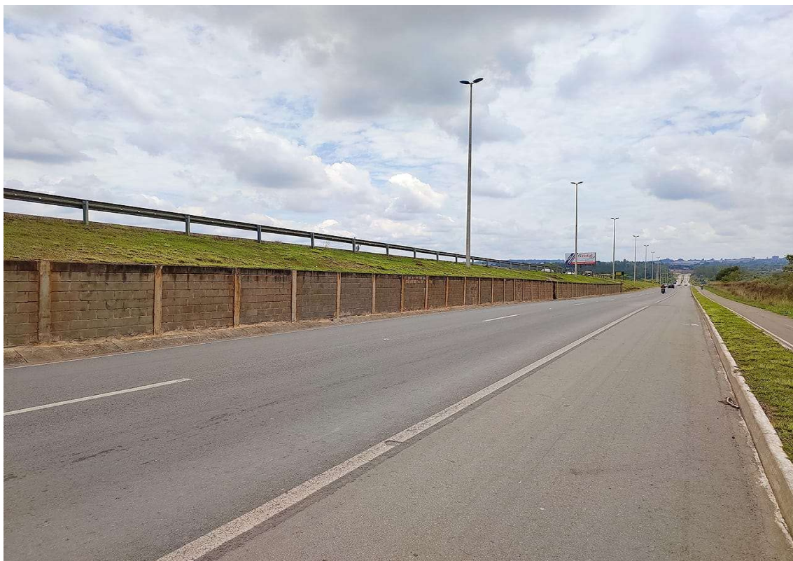
Figura 14: Trecho da rodovia GO-020, à esquerda da imagem, é possível visualizar a presença de um muro de arrimo, sem a presença de algum túnel de acesso para o outro lado da rodovia.
