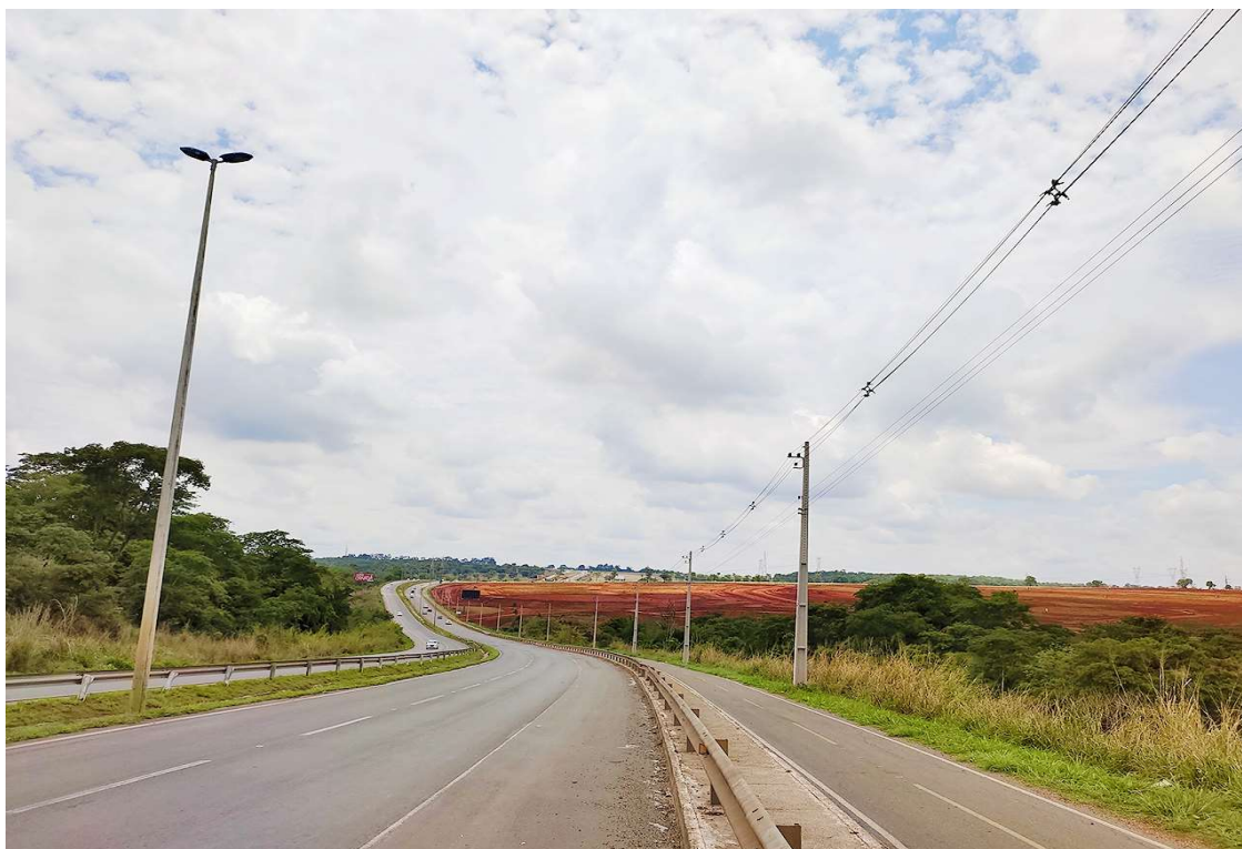
Figura 2: Trecho da rodovia GO-020 sentido Goiânia - Senador Canedo. Observa-se área de desmatamento à direita e área de mata preservada à esquerda.
