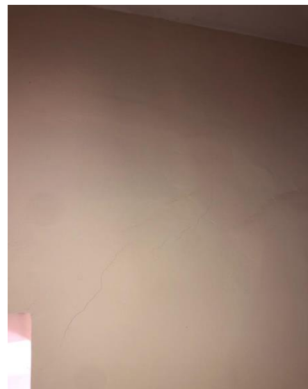
Depois ( 5 meses após a reforma)
