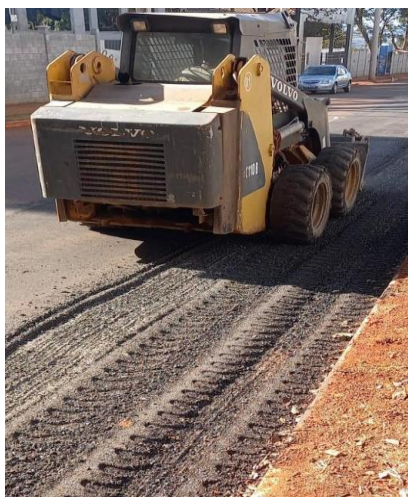
Figura 10 – Bobcat fresadora retirando o asfalto antigo.
