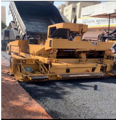
Figura 11 – Massa asfáltica sendo descarregada no silo da vibroacabadora e espalhada no trecho.
