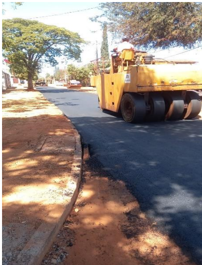
Figura 12 – Trecho sendo compactado com o rolo pneumático.
