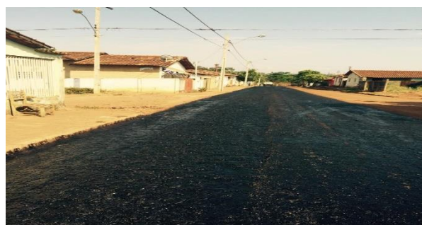
Figura 2 – Trecho de uma rua com o banho de ligação executado.
