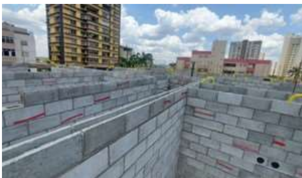
Figura 2 – Paredes de alvenaria estrutural na obra Wish Aeroporto em Goiânia/GO, Dos autores (2022).
