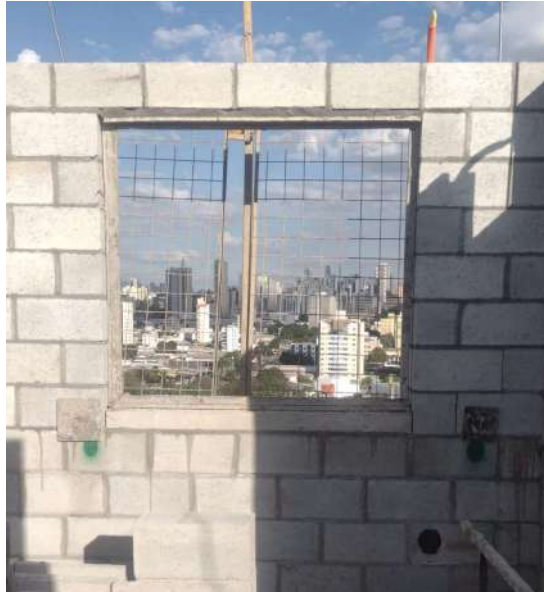
Figura 6 – Execução da última fiada como verga para vãos na obra Wish Aeroporto em Goiânia/GO, Dos autores (2022).
