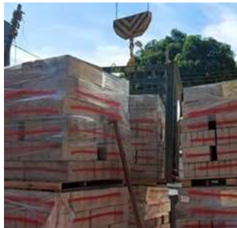
Figura 7 – Blocos estruturais de 20 MPa na obra Wish Aeroporto em Goiânia/GO, Dos autores (2022).
