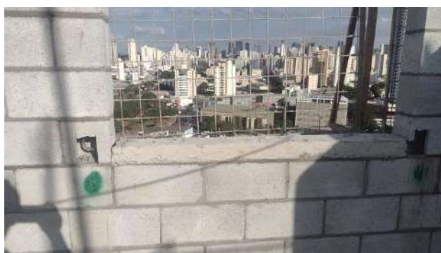
Figura 5 – Aplicação de contra verga na parede de alvenaria na obra Wish Aeroporto em Goiânia/GO, Dos autores (2022).
