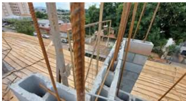
Figura 4 – Posicionamento e amarração da armadura da alvenaria na obra Wish Aeroporto em Goiânia/GO, Dos autores (2022).
