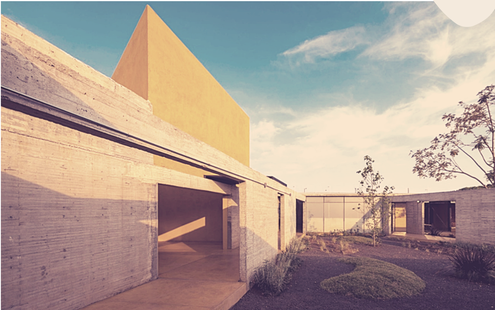
IMAGEM 9 - Fachada da edificação Fonte: Archivo Baq, 2022.
