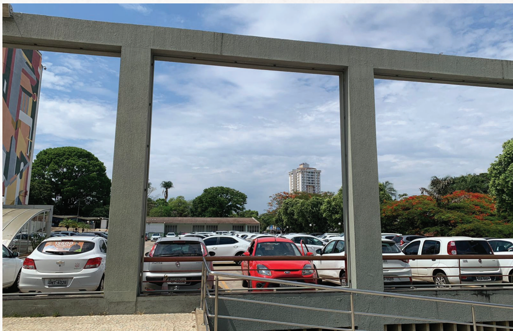
VISTA DO ESTACIONAMENTO TÉRREO - ÁREA II
