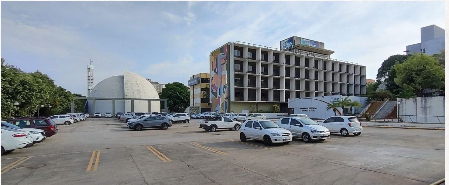
VISTA DO ESTACIONAMENTO TÉRREO - ÁREA II
