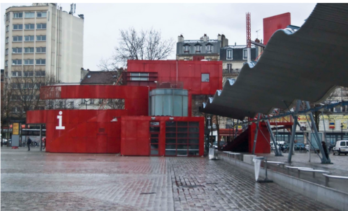
Imagem 77. Edifício 01 localizado no Parque. Fonte: www.archdaily.com.br/
