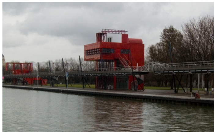
Imagem 78. Edifício 02 localizado no Parque. Fonte: www.archdaily.com.br/
