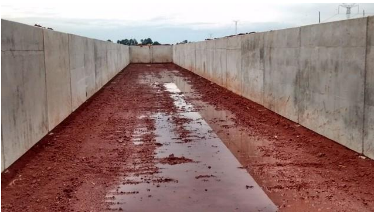
Figura 7- Silo Trincheira cimentado
