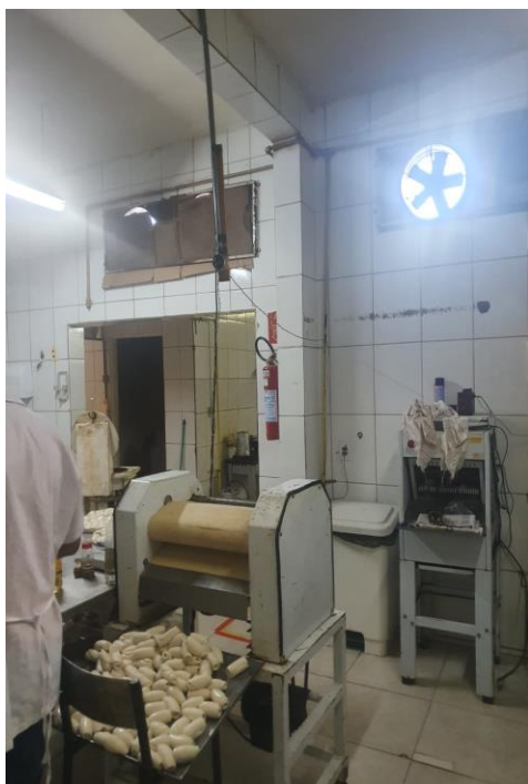
Figura 3 - Condutores expostos
