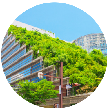
Figura 3: Telhado verde Fonte: https://www.dinamicambiental.com.br/
