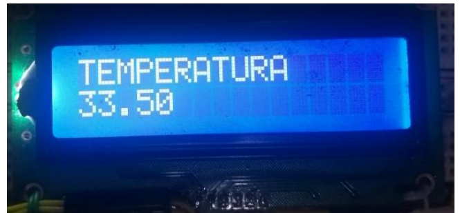
Figura 23 - Temperatura do transformador indicada no LCD
