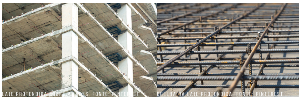
LAJE PROTENDIDA SOBRE PILARES. FONTE: PINTEREST
