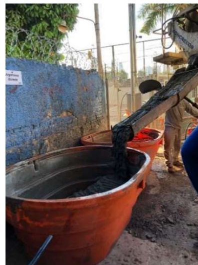
Figura 4 – Descarga de argamassa estabilizada
