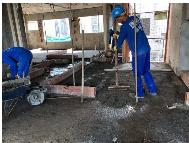
Figura 8 – Execução do contrapiso
