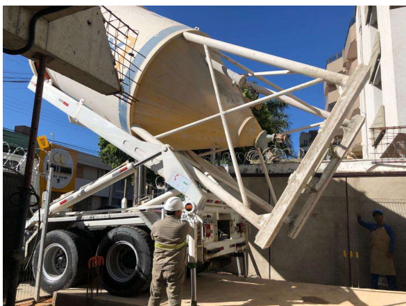
Figura 5 – Instalação do silo em canteiro de obra
