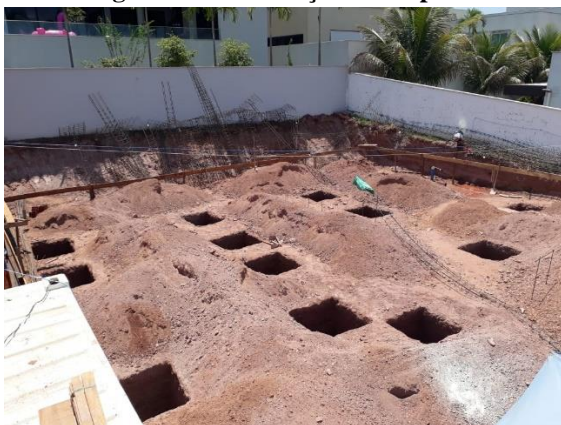
Figura 12 – Escavação das sapatas
