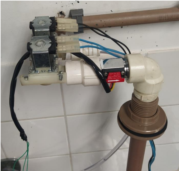
Figura 11 - Válvulas solenoides e sensor de fluxo
