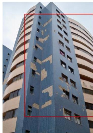
Nota-se, na Figura 22 áreas grandes com descolamento de revestimento. Nos pilares foram executadas juntas falsas, ou seja, sem preenchimento com material elástico (Figura 23).
