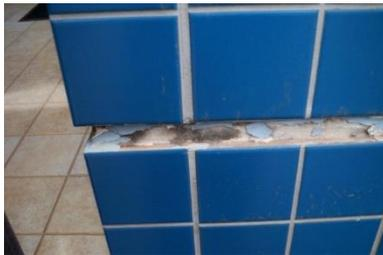
A Figura 24 apresenta uma situação mista onde houve falha tanto no assentamento da pastilha como também no processo de colagem da pastilha. Há falha da argamassa de assentamento conjuntamente com o emboço este último com vazios próprios de uma execução deficiente.
