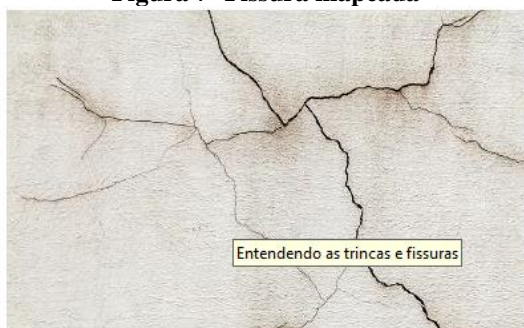
Figura 7- Fissura mapeada
