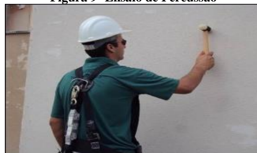
Figura 9- Ensaio de Percussão
