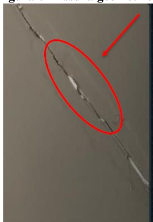
Figura 6- Fissura geométrica
