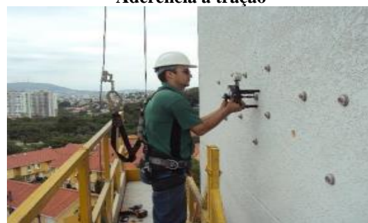
Figura 10- Ensaio de Arrancamento ou Ensaio de Aderência à tração
