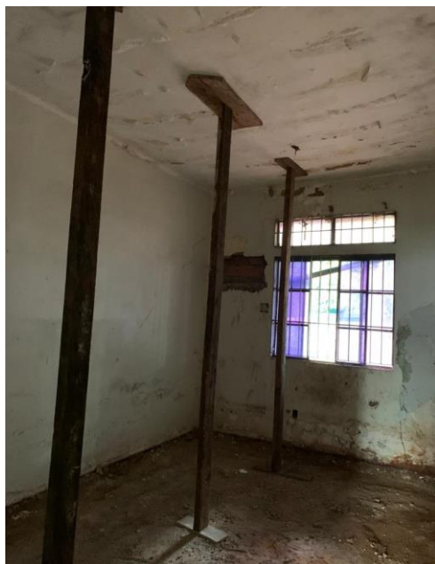
Figura 12 – Teto escorado da antiga chefatura do estado de Goiás atualmente.
