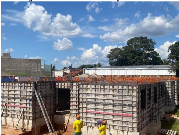
Figura 9 – Fôrmas metálicas posicionadas
