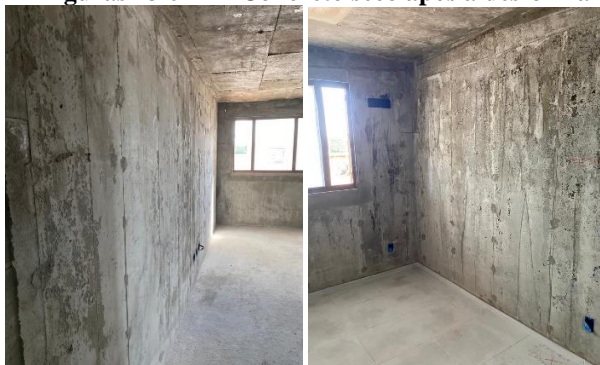
Figuras 13 e 14 – Concreto seco após a desfôrma
