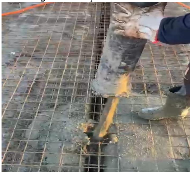
Figura 12 – Lançamento do concreto
