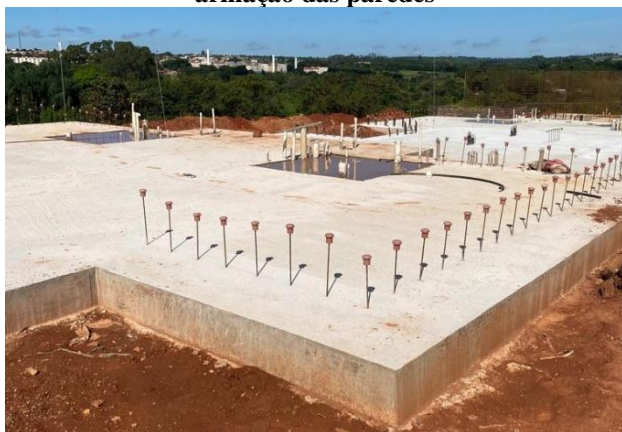
Figura 5 – Arranques no radier para continuidade da armação das paredes
