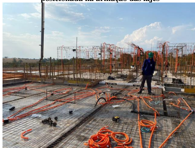
Figura 8 – Instalações elétricas e hidráulicas posicionada na armação das lajes
