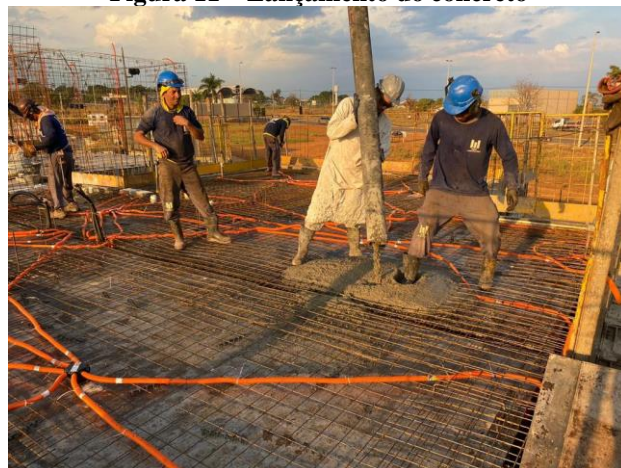
Figura 11 – Lançamento do concreto
