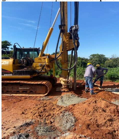
Figura 01 – Perfuração de estacas tipo hélice
