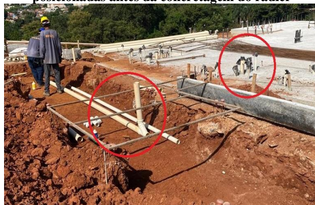
Figura 03 – Tubulações hidráulicas e elétricas sendo posicionadas antes da concretagem do radier
