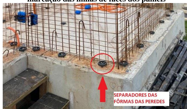
Figura 4 – Separadores posicionados entre a marcação das linhas de faces dos painéis
