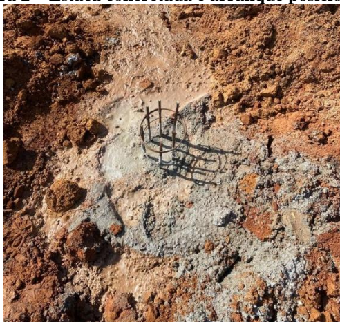
Figura 2 – Estaca concretada e arranque posicionado
