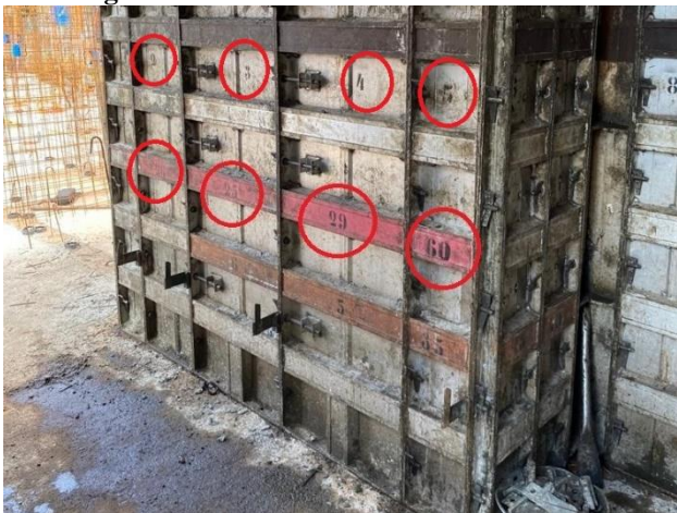
Figura 10 – Fôrmas metálicas enumeradas
