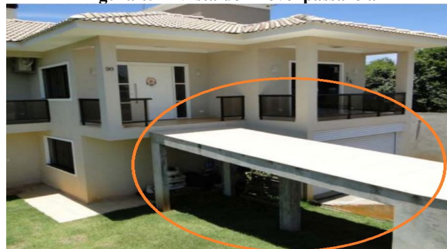
Figura 09 – Vista do imóvel passarela
