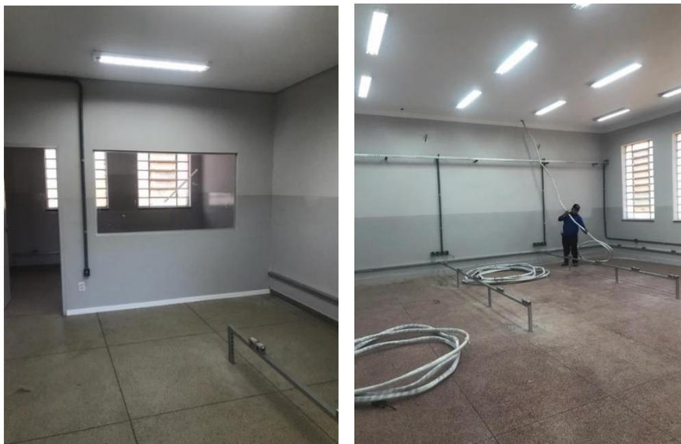
As salas receberam novas luminárias as quais propiciam uma visualização melhor do ambiente, e desempenhem tarefas visuais de maneira mais eficiente, precisa e segura, sem causar fadiga visual e desconforto, assim como determina a norma NBR 16401/2008. As luminárias escolhidas são do tipo calha para lâmpadas de LED. A lâmpada escolhida é integrada a luminária, ela é tubular LED de 18 W de potência e 2000 lumens, um índice de cor de 80.
