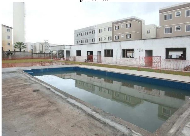
Figura 18 – Área de lazer e Bloco 8 em fase de pintura.
