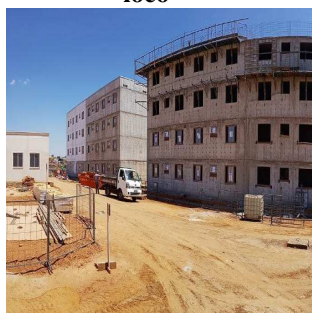
Figura 3 – Paredes de concreto moldado “in loco”
