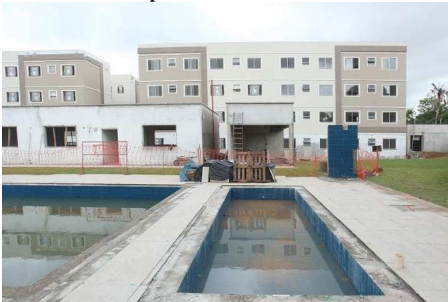
Figura 17 – Área de lazer e edifício realizado com paredes de CRFV
