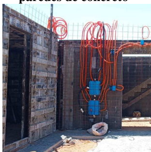
Figura 2 – Instalações elétricas em telas de paredes de concreto
