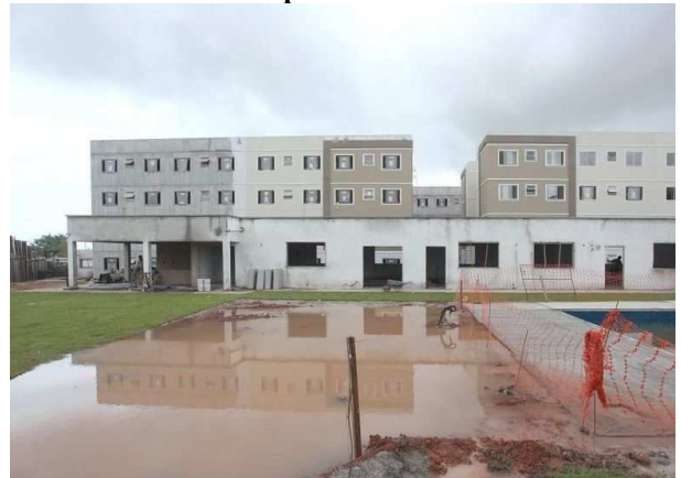
Figura 19 – Área de lazer e Bloco 8 em fase de pintura.
