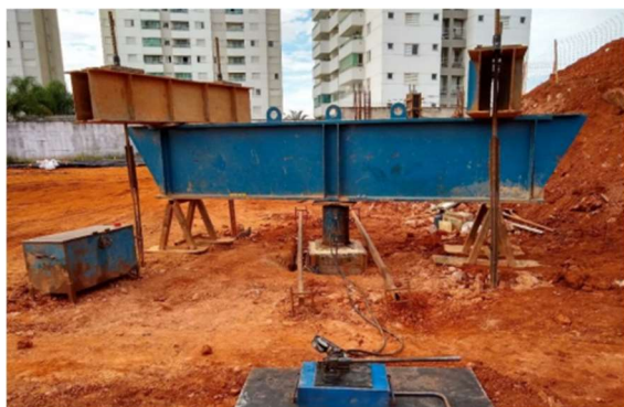
Figura 1 – Sistema de reação e dispositivo de aplicação de carga.
