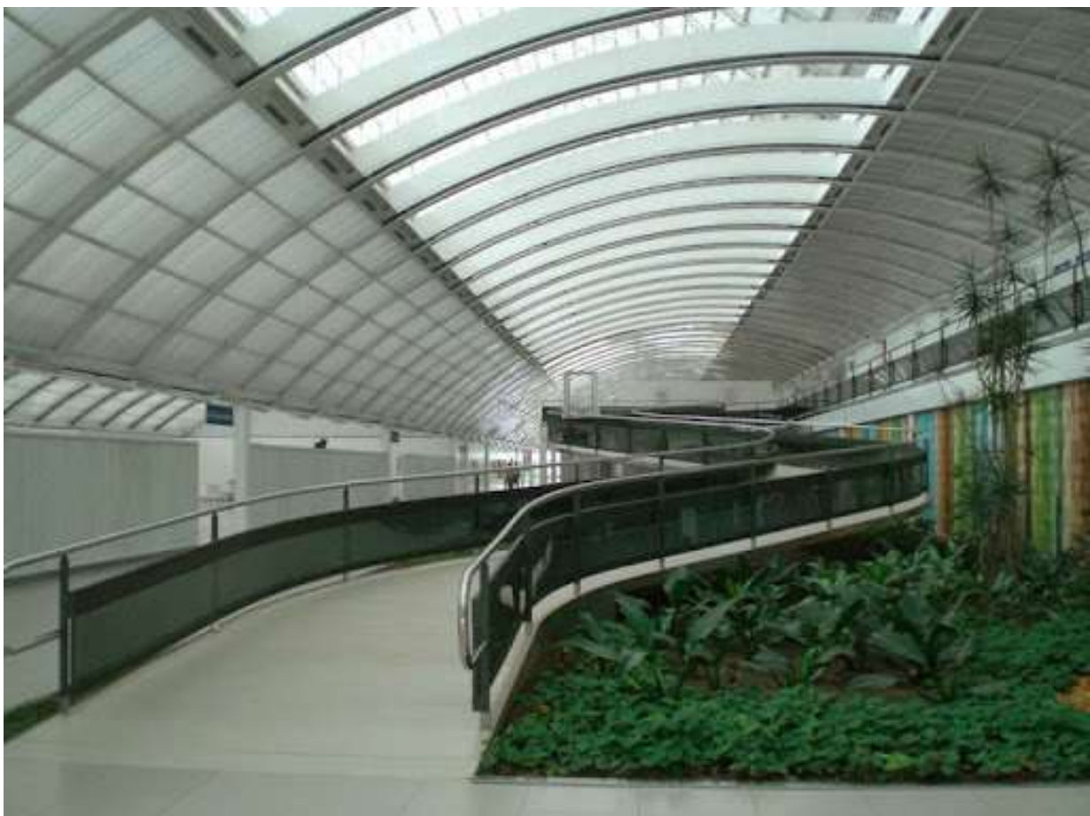
Circulações e jardim interno. Fonte: Google Imagens
