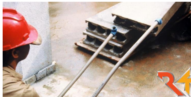
Figura 4 –Passagem de tubulação hidráulica nos painéis.
