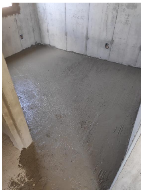
Figura 8 – Fotografia do preenchimento de uma laje irregular
