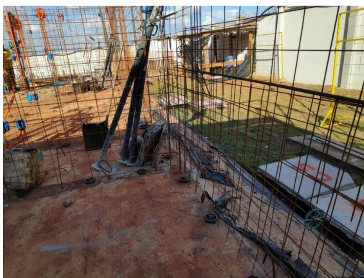
Figura 3 – Fotografia das telas, nas armações da parede de concreto armado
