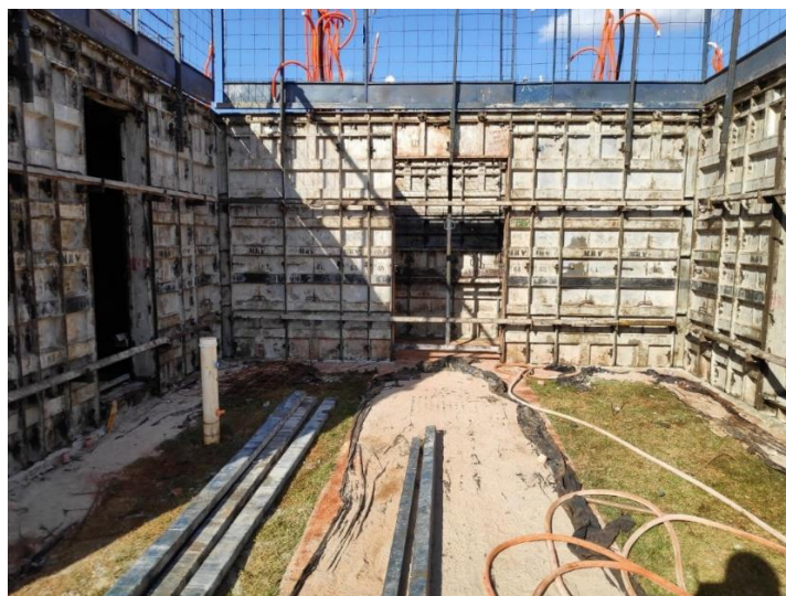
Figura 1 – Fotografia das formas metálicas das paredes de concreto moldadas in loco .
