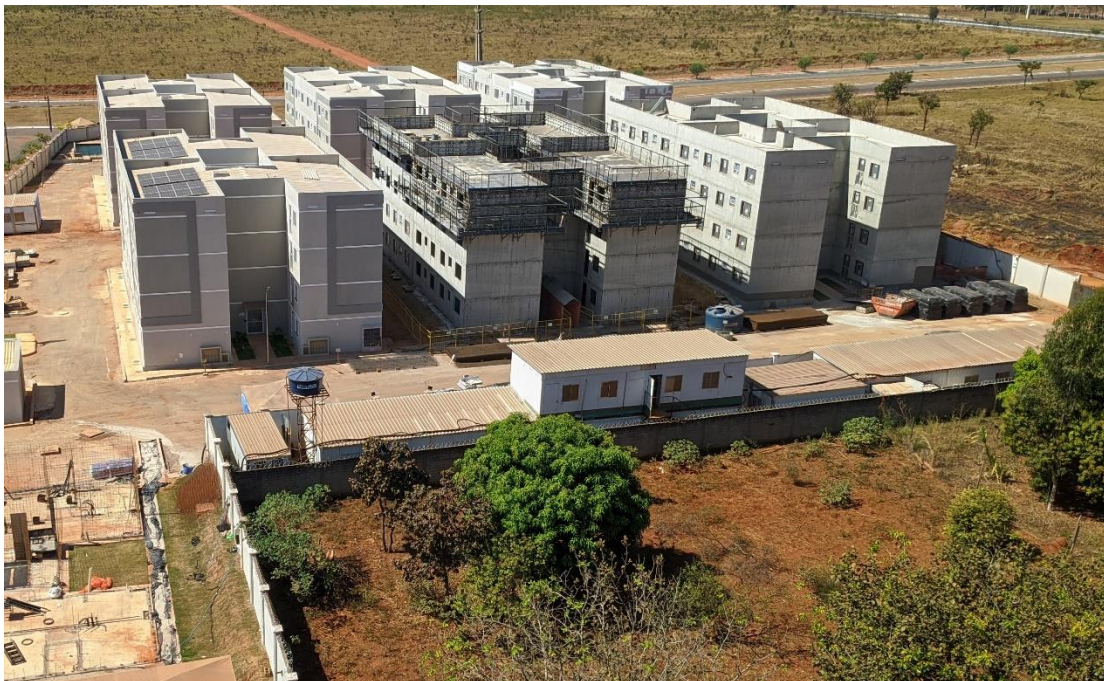
Figura 9 – Vista aérea de uma obra com uso do método executivo de paredes de concreto moldadas in loco
