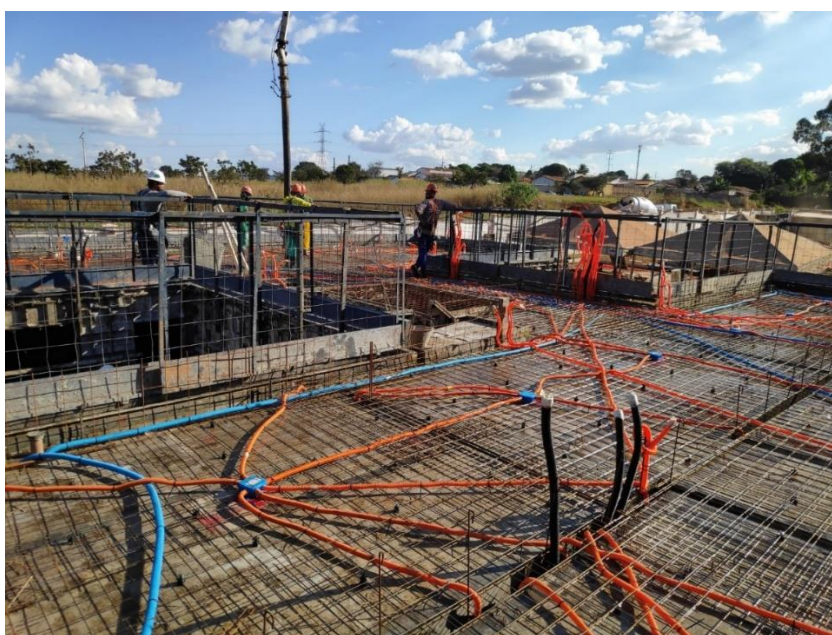
Figura 4 – Fotografia da concretagem das paredes de concreto armado
