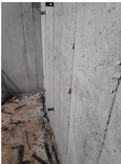
Figura 7 – Fotografia de uma parede
