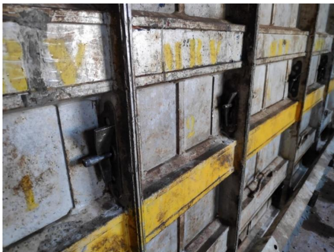
Figura 2 – Fotografia dos travamentos usados nas formas metálicas de paredes de concreto.
