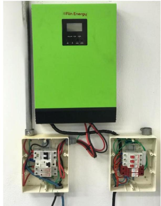
Fig.8. Chegada da c.c. no QDG / Inversor / QDG do c.a.
