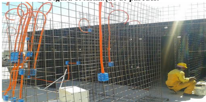
Figura 8: Armação de paredes.
