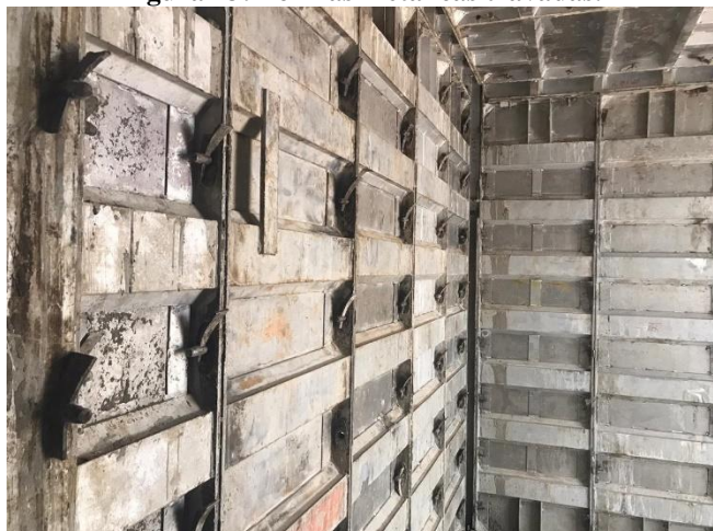
Figura 13: Fôrmas metálicas travadas.
