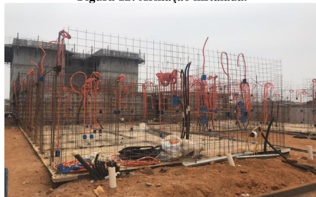
Figura 12: Armação instalada.
