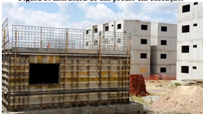
Figura 3: Estrutura de um prédio em execução.
