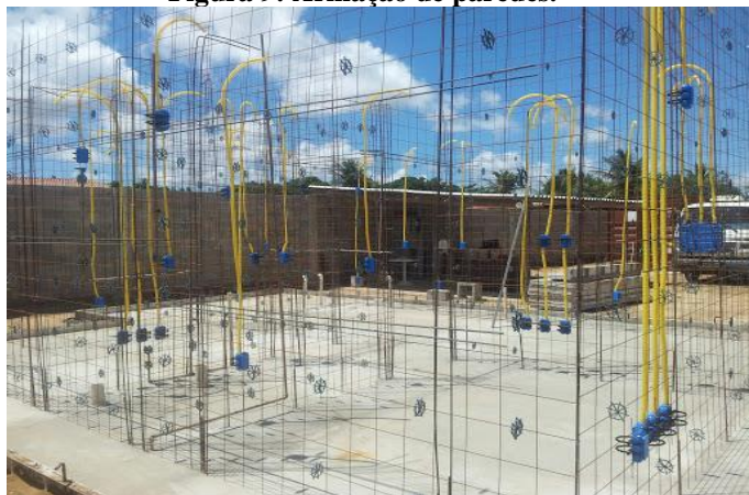
Figura 9: Armação de paredes.
