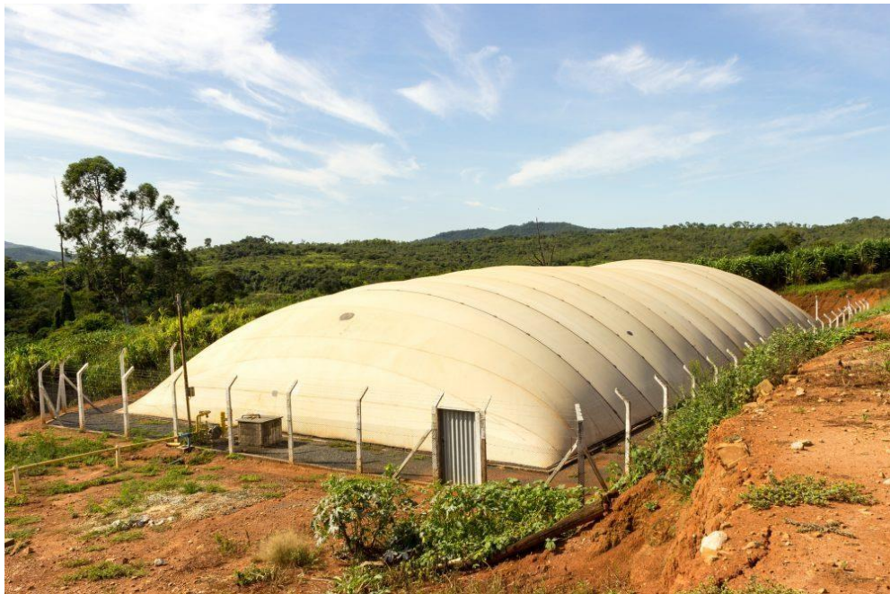
Figura 1 - Biodigestor anaeróbico. Fonte: Suçarana, (2015).
