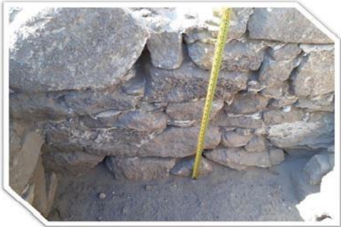
Figura 9: Vista detalhada da estrutura da parte interna. Fonte: CONSAM (2017)
