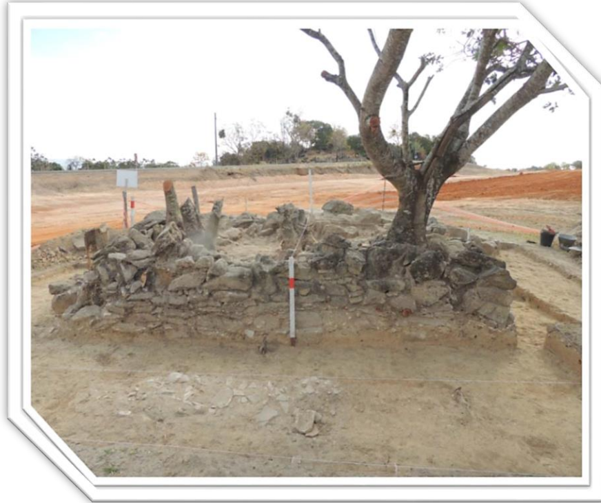
Figura 28: Vista geral da estrutura da Capela. Fonte: CONSAM (2021)
