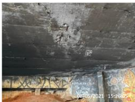
Figura 09- Armadura expostas.
