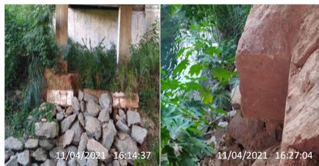
Figura 07- Blocos e estacas de fundação expostas.
