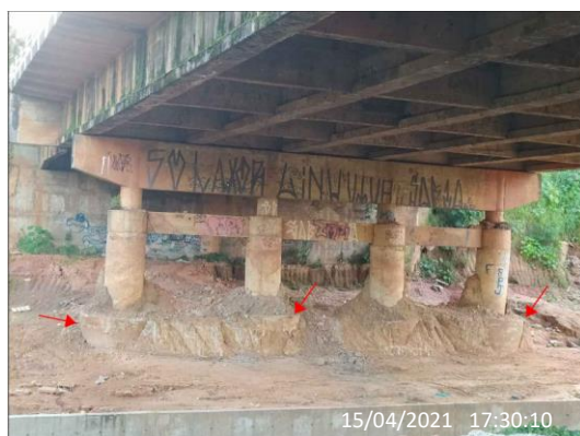
Figura 06- Blocos de fundação expostos.
