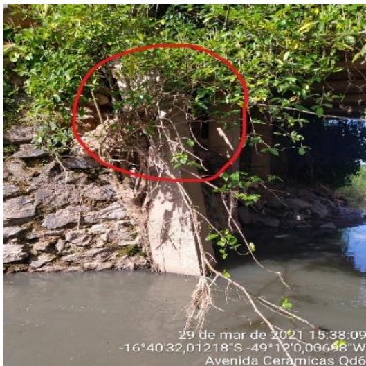
Figura 03- Pilar rompido.
