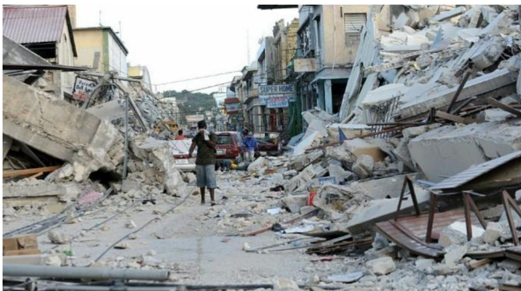
Figura 7: Destruição causada pelo terremoto de 2010
