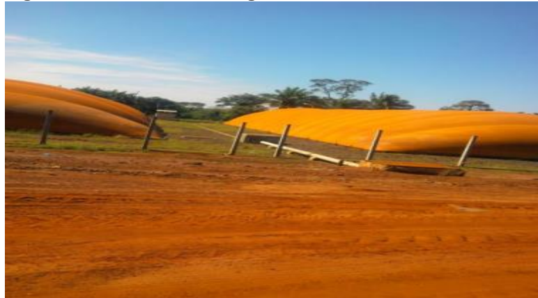
Figura 07 - Modelo de biodigestor canadense
