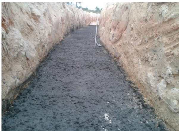
Figura 4: Lastro de concreto magro.
