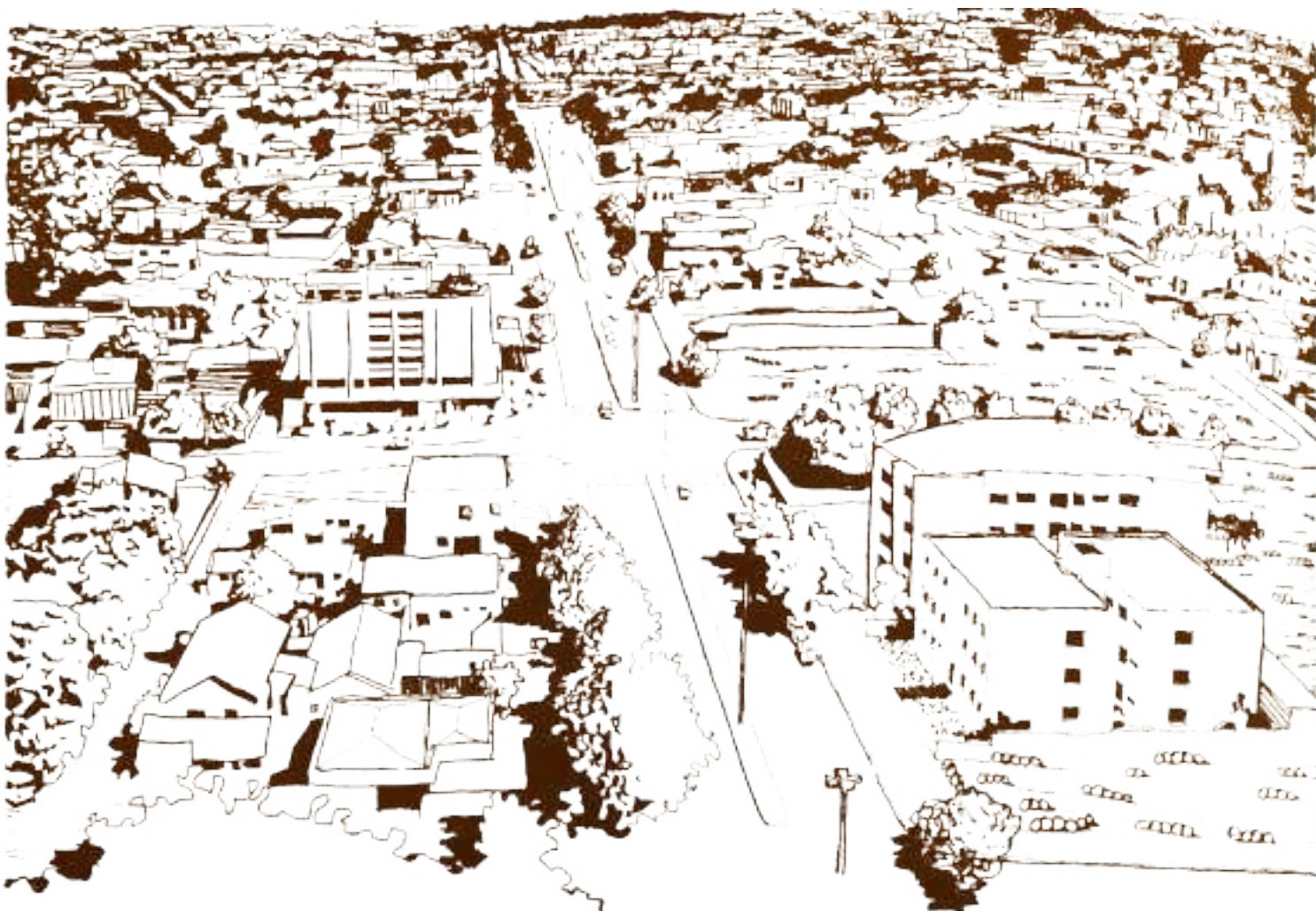
Vista aérea parcial do Setor Sul
