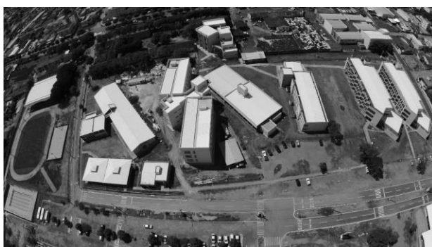
Figura 11: Universidade Federal de Catalão. Fonte: Site Ufg-Regional Catalão.
