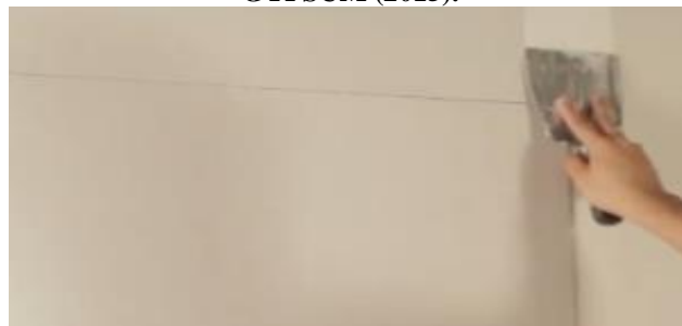
Figura 8: Acabamento com massa corrida. Fonte: GYPSUM (2015).
