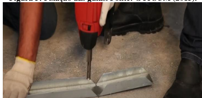
Figura 5: Fixação das guias. Fonte: GYPSUM (2015).
