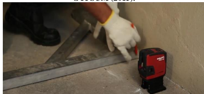
Figura 4: Marcação das divisórias no piso. Fonte: GYPSUM (2015).
