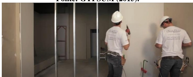
Figura 7: Chapeamento das placas de gesso acartonado. Fonte: GYPSUM (2015).
