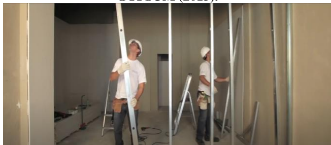
Figura 6: Paginação dos montantes nas guias. Fonte: GYPSUM (2015).
