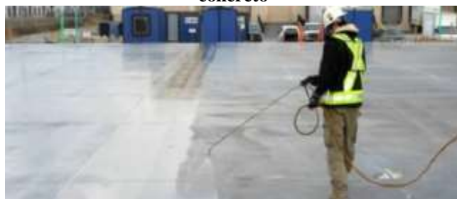
Figura 04 – Consumo de água no processo de cura do concreto
