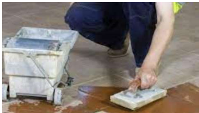
Figura 05 – Limpeza pós-obra é fundamental
