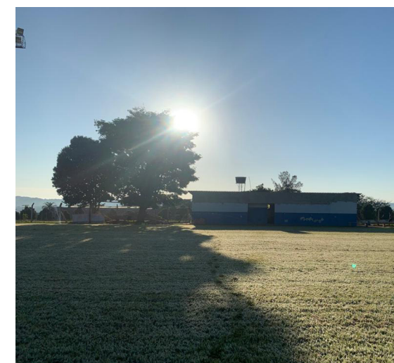
Figura 3.3.2 Vestiários existentes no local
