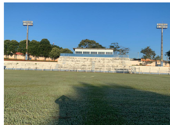
Figura 3.31. Arquibancada e Sala de Rádio existente no local
