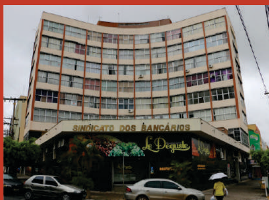
Fachada do Edifício 28 de Agosto.
