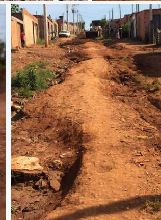
Figura 47 - PROBLEMAS DE INFRAESTRUTURA Fonte : Celso (Associação dos moradores)
