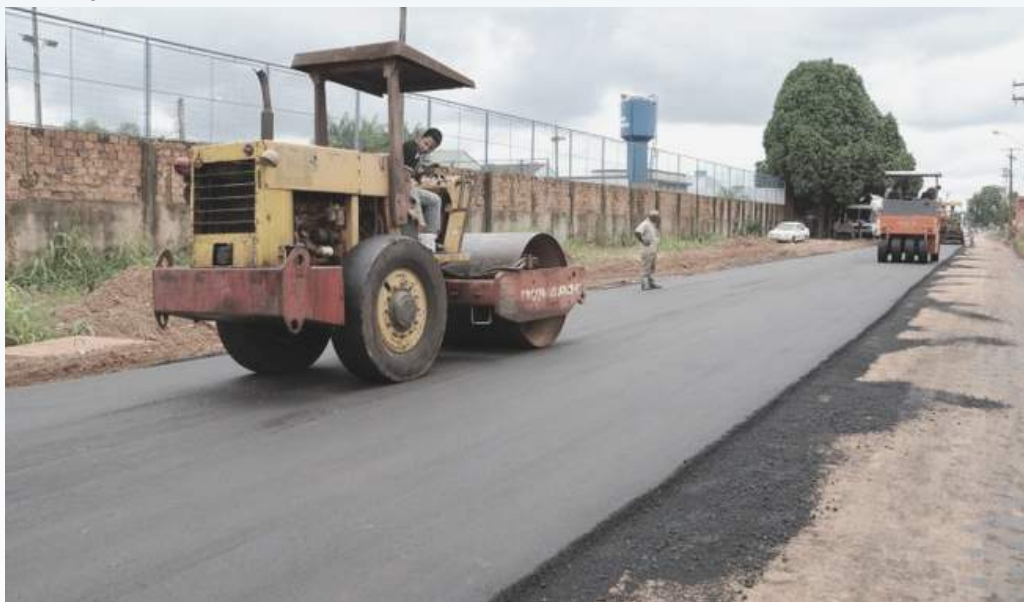
Figura 71- Pavimentação de via urbana Fonte: Google
