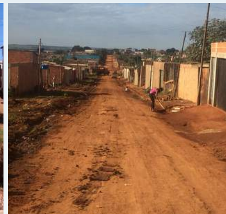
Figura 45 - RUAS SEM PAVIMENTAÇÃO - Rua Manoel Darrigrand Fonte: Celso (Associação dos moradores)
