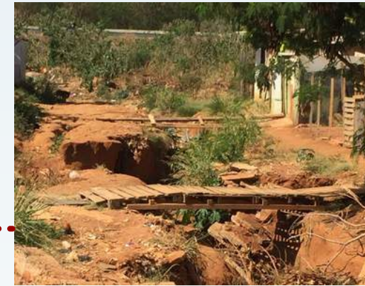
Figura 37 - EROSÃO CAUSADA PELA CHUVA Fonte: Associação de Moradores
