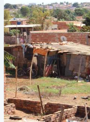
HABITAÇÕES PRECÁRIAS Figura 21 - Registro do assentamento Fonte: Celso (Associação dos moradores)
