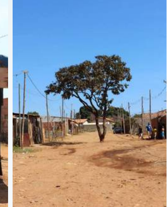
RUAS SEM PAVIMENTAÇÃO Figura 23 - Registro do assentamento Fonte: Celso (Associação dos moradores)
