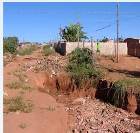
Figura 44 - ÁREA DE EROSÃO - Rua Frei Tito Fonte: Celso (Associação dos moradores)
