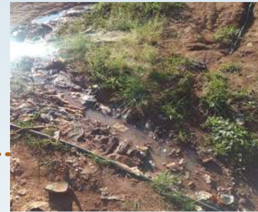
Figura 36 - ESGOTO A CÉU ABERTO Fonte: Associação de Moradores
