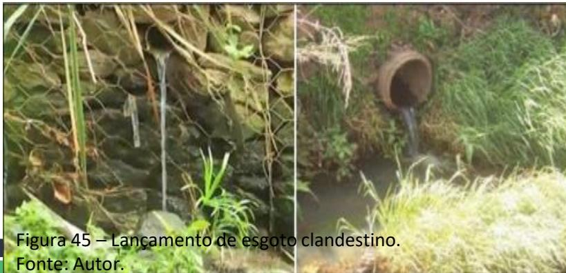
Figura 45 – Lançamento de esgoto clandestino.
