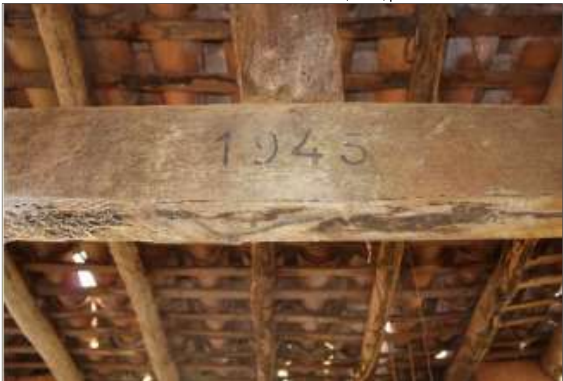
Figura 22: Fábrica (galpão). Registro cronológico no madeiramento do telhado da varanda que fica no sentido Oeste. Fonte: A LASCA, 2020, p.108.
