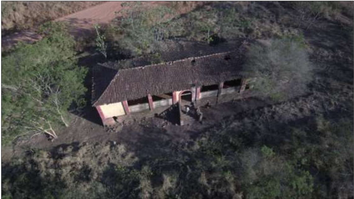
Figura 12: Sítio Facão II, área 1 - Fábrica (galpão). Telhado com quatro águas e fachada principal, com destaque para escadaria. Imagem área obtida por VANT (Drone). Fonte: A LASCA, 2020, p.105.
