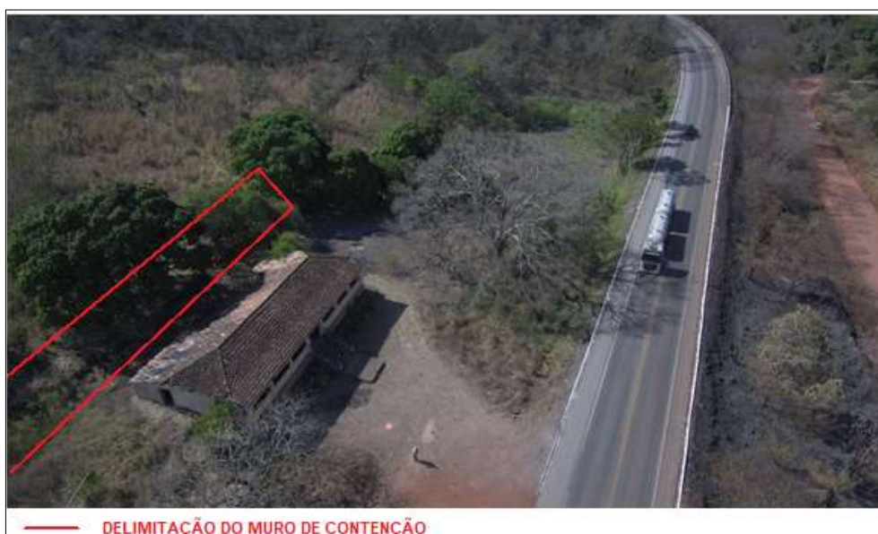
Figura 30: Sítio Facão II, área 2 - Escola e Capela. Vista aérea da escola, com a BR-070 na frente, e muro de contenção ao fundo. A LASCA, 2020.
