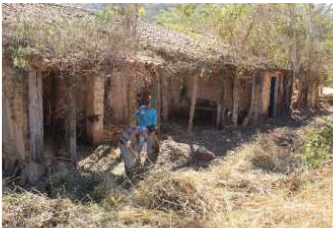
Figura 20: Sítio Facão II, área 1 – Fábrica (galpão). Vista geral da varanda no sentido Sul do Prédio da Fábrica. Fonte: A LASCA, 2020, p.107.
