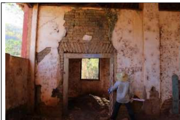
Figura 18: Sítio Facão II, área 1 - Fábrica (galpão). Registro da parede de adobão. Fonte: A LASCA, 2020, p.106.
