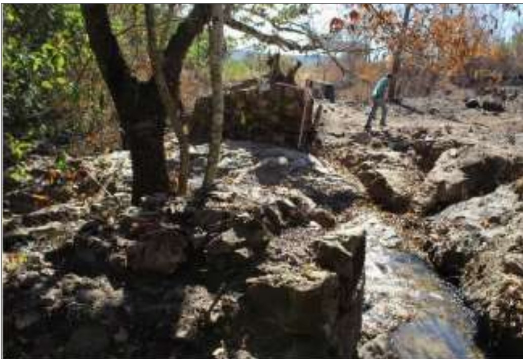
Figura 33: Sítio Facão II, área 3 - Usina Facão. Área colapsada da Barragem. Fonte: A LASCA, 2020, p.120.
