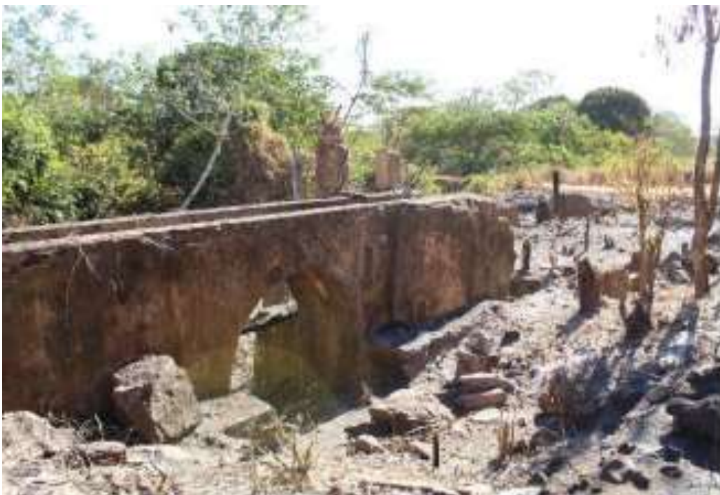
Figura 37: Sítio Facão II, área 3 - Usina Facão. Registro do aqueduto, parte final do conduto aéreo. Fonte: A LASCA, 2020, p.121.
