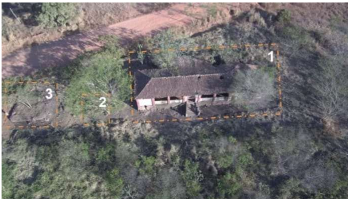
Figura 14: Sítio Facão II, área 1 - Fábrica (galpão), e suas três estruturas: 1-Prédio da Fábrica (galpão); 2-Alicerce 1; 3-Alicerce 2. Imagem área obtida por VANT (Drone). Fonte: A LASCA, 2020, p.103.
