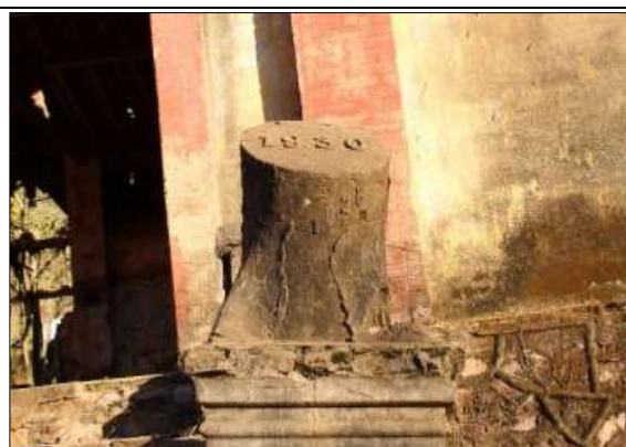
Figura 17: Sítio Facão II, área 1 - Fábrica (galpão). Marco cronológico em alto relevo junto à escadaria principal, com inscrições “1928” e “1930”. Fonte: A LASCA, 2020, p.105.
