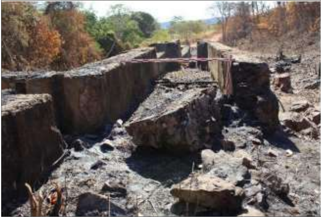
Figura 36: Sítio Facão II, área 3 - Usina Facão. Área colapsada. Observa-se composição de material misto na construção. Fonte: A LASCA, 2020, p.121.
