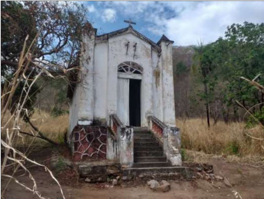
Figura 28: Sítio Facão II, área 2 - Escola e Capela. Aspectos fachada da capela. A LASCA,2020.
