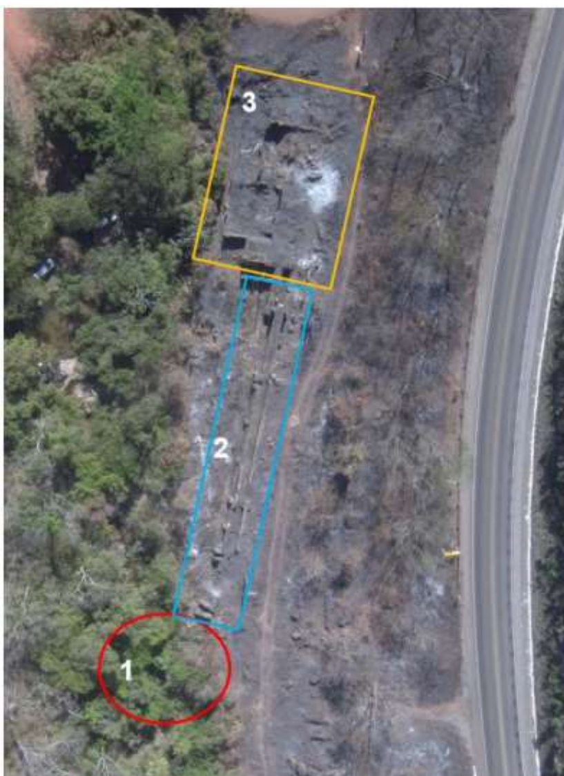
Figura 32: Sítio Facão II, área 3 - Usina Facão, e suas três estruturas: 1-Barragem; 2-Canal de Adução (aqueduto); 3- Casa de Força e Estruturas de Produção. Imagem do dispositivo VANT (Drone). Fonte: A LASCA, 2020, p.118.
