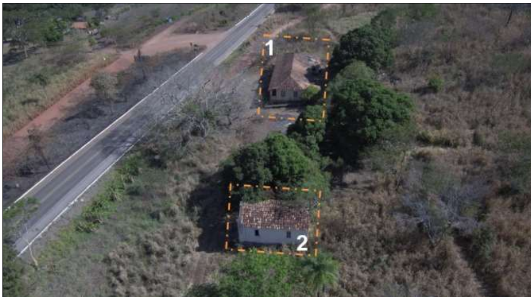
Figura 29: Sítio Facão II, área 2 - Escola e Capela, e suas duas estruturas: 1-Prédio da Escola; 2- Prédio da Capela. Imagem do dispositivo VANT (Drone). Fonte: A LASCA, 2020. Fonte: A LASCA, 2020, p.113.
