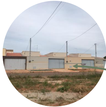
Figura 10 – Residências PMCMV Fonte: Autoral
