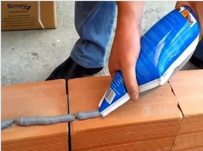
Figura 32 - Argamassa Biomassa Fonte: Razões para acreditar
