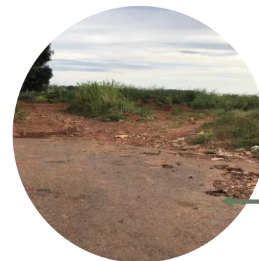
Figura 12 – Final da estrutura viária Fonte: Autoral
