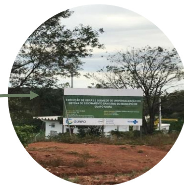
Figura 16 – Obra de Esgotamento Fonte: Autoral
