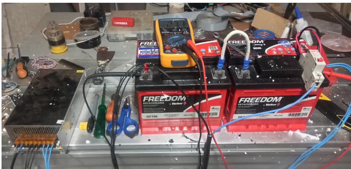
Figura 63: Montagem das baterias
