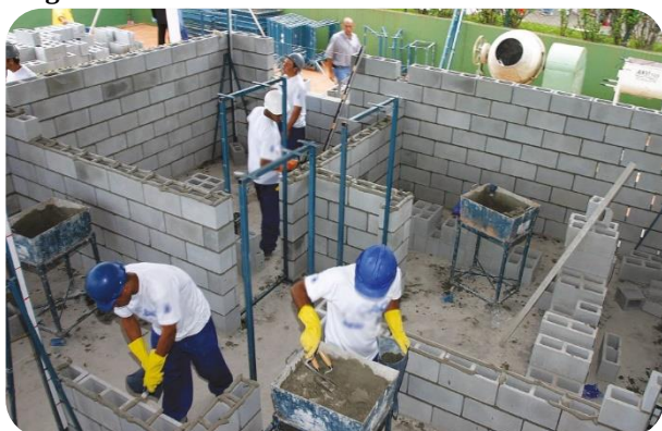
Figura 5 – Alvenaria estrutural de bloco de concreto
