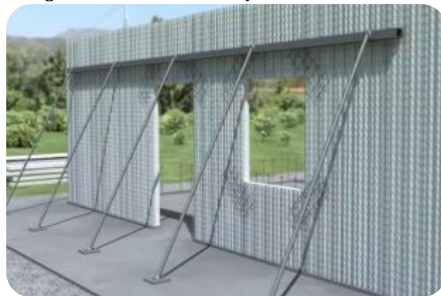
Figura 9 – Parede com função estrutural em EPS
