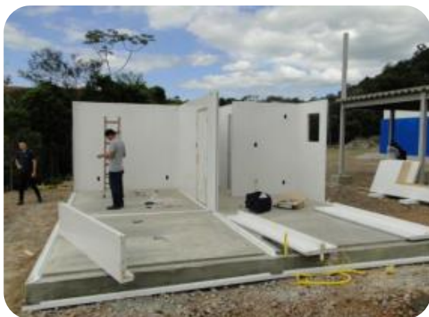
Figura 10 – Painel pré fabricado com chapa zincada com núcleo termoacústico.
