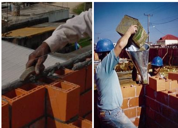
Figura 4 – Execução de alvenaria estrutural em bloco cerâmico
