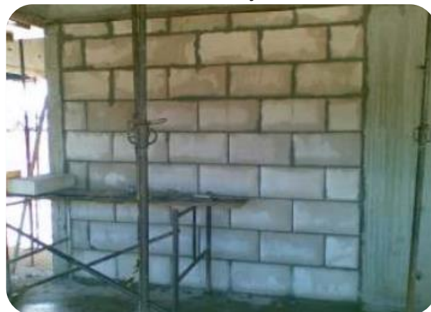
Figura 6 – Alvenaria de bloco de concreto celular autoclavado sem função estrutural
